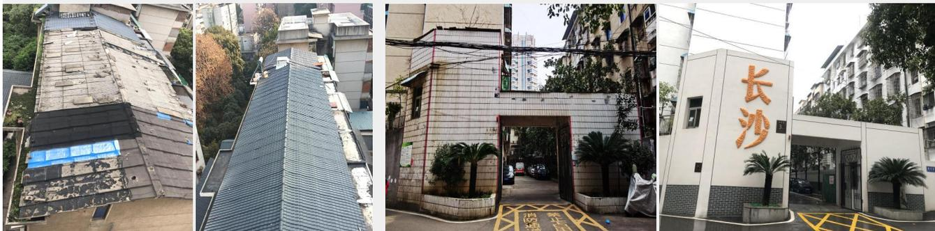
原屋面存在老化破坏、渗漏的情况，进行屋顶防水改造，解决屋顶漏水问题
