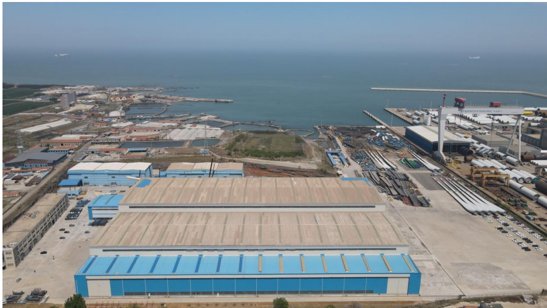
图 7—4 盘活利用后项目航拍照片
