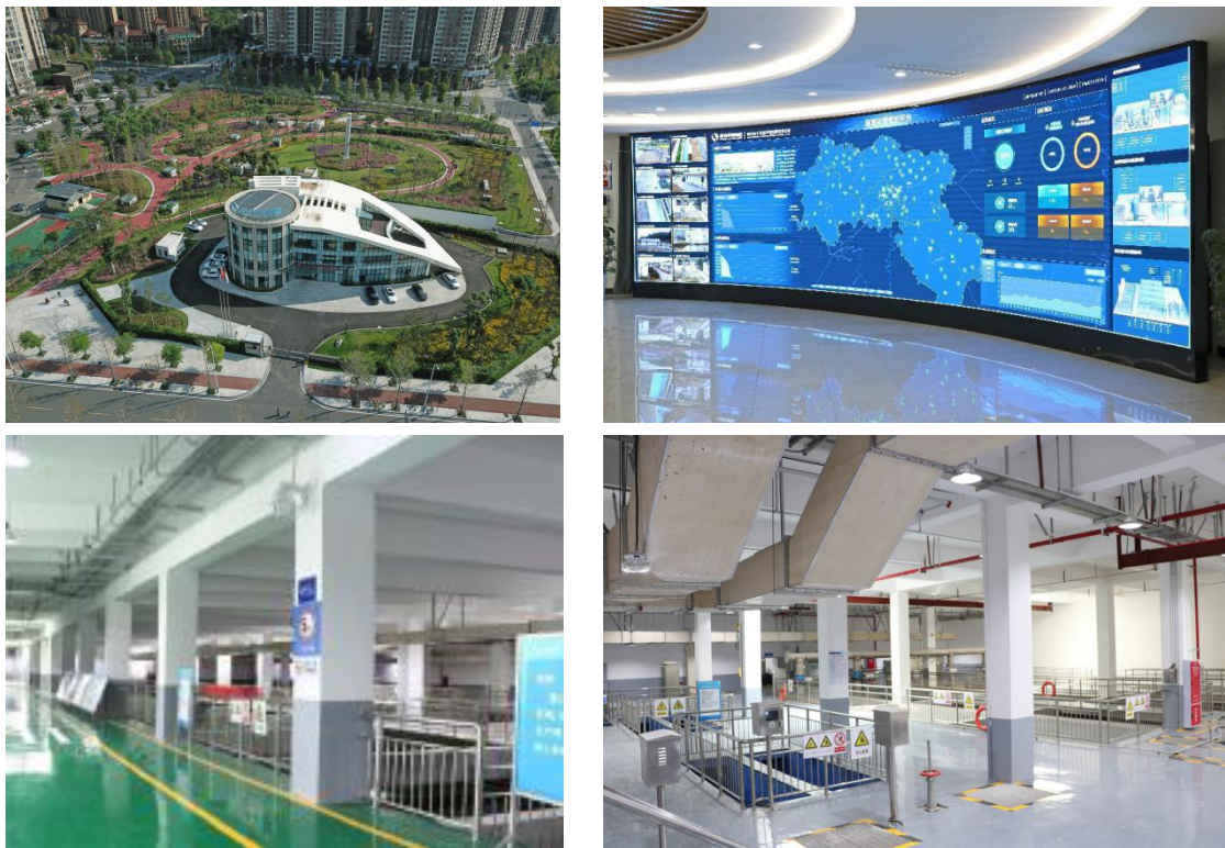
图 33—4 谢家河再生水厂实拍图
