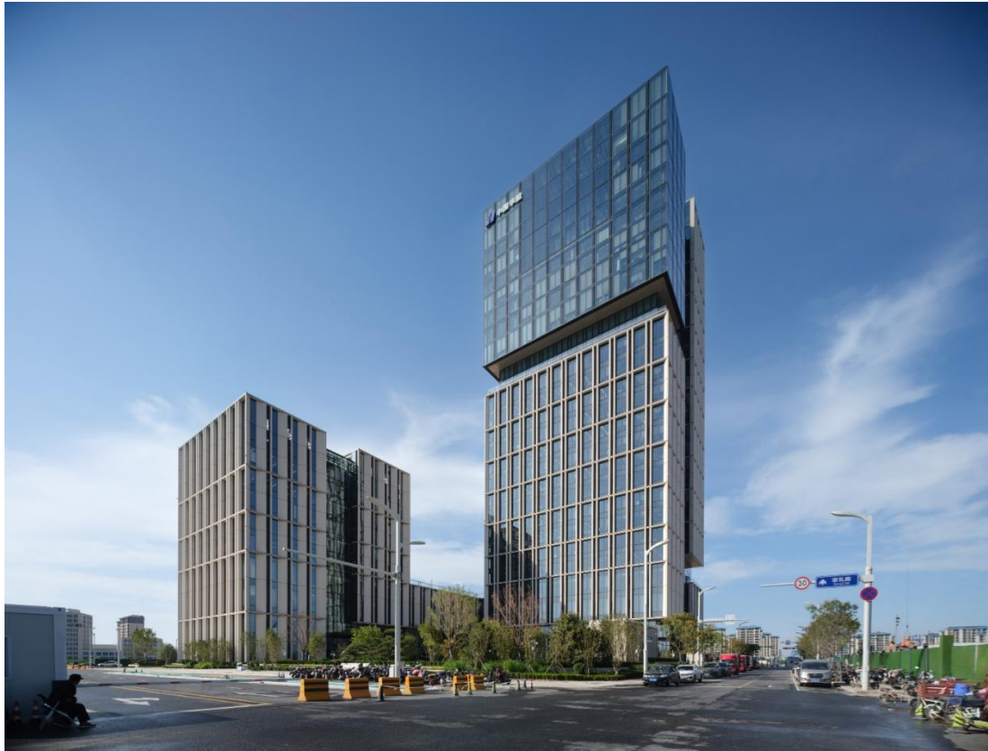
图 1—1 中国华能雄安总部一期项目实景图
