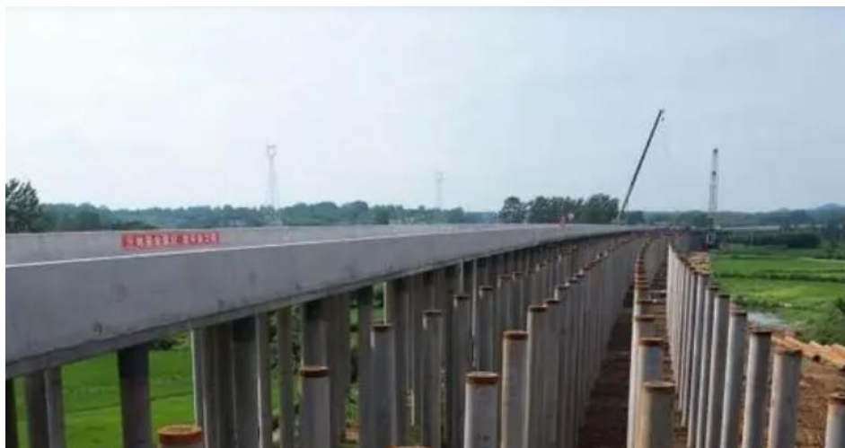
图 37—2 桩板式结构示意图
