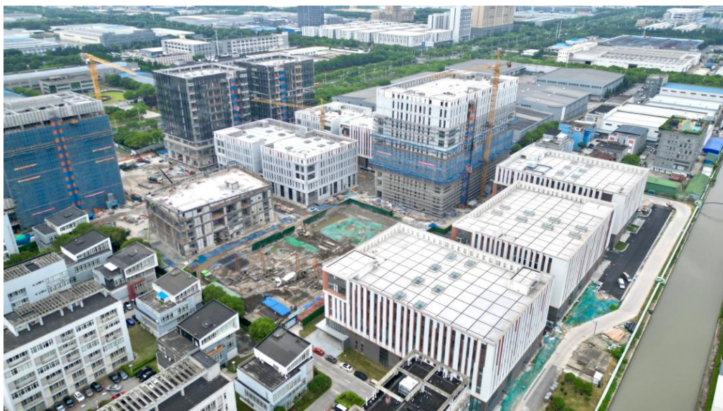
图 45—3 中德双元制职业教育产业园项目施工现场图
