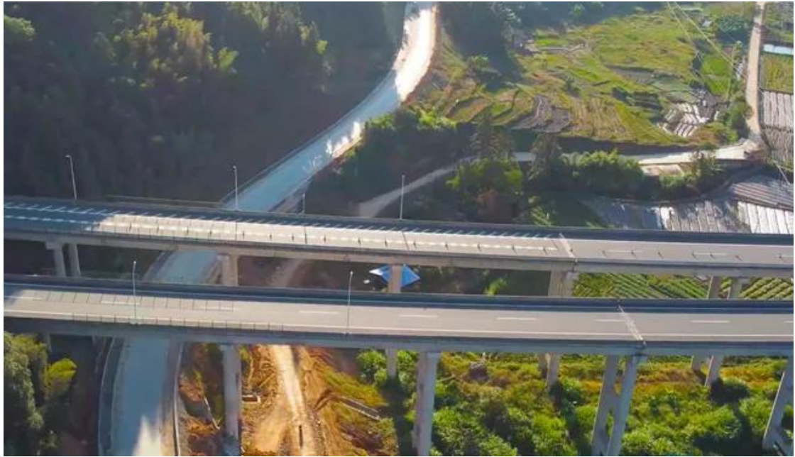
图 40—4 尤溪西城至新阳（大田界）公路桥梁工程
