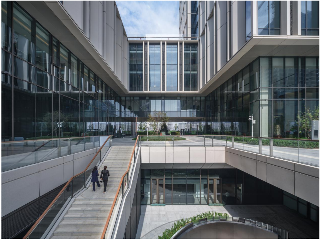
图 1—2 中国华能雄安总部一期项目地下庭院实景图
