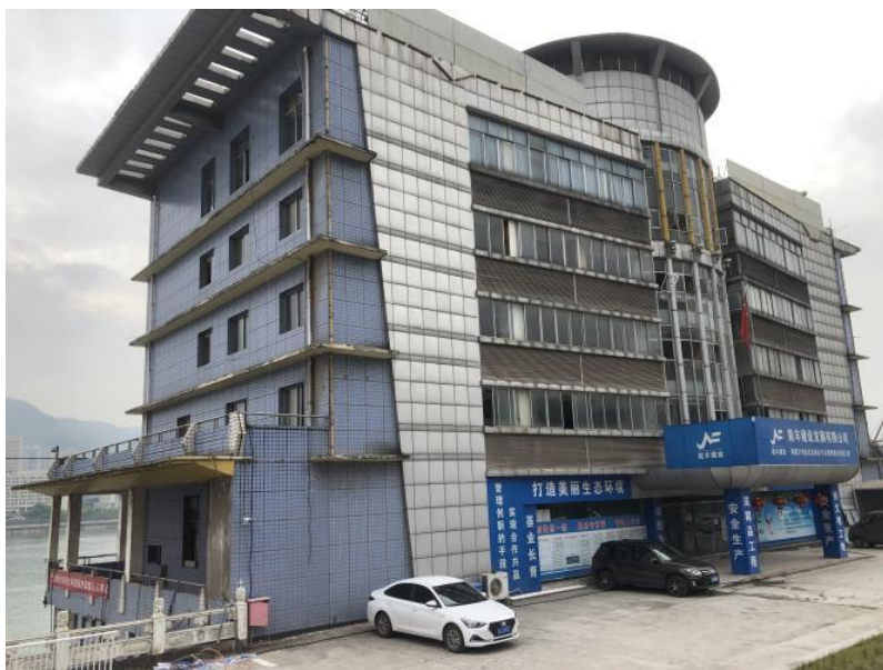
图 48—1 港航办公大楼改造前
