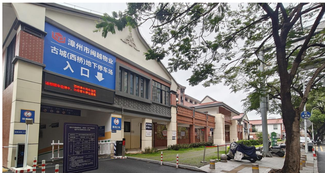
图 27—3 漳州市西桥中心小学地下公共停车场
