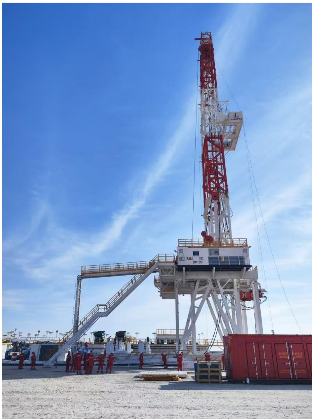
图 41—1 “油田医院”节地技术示范项目施工作业现场
