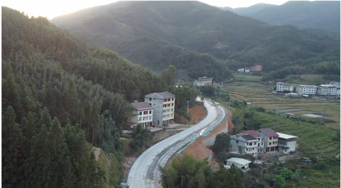
图 40—3 尤溪西城至新阳（大田界）公路工程项目施工照片
