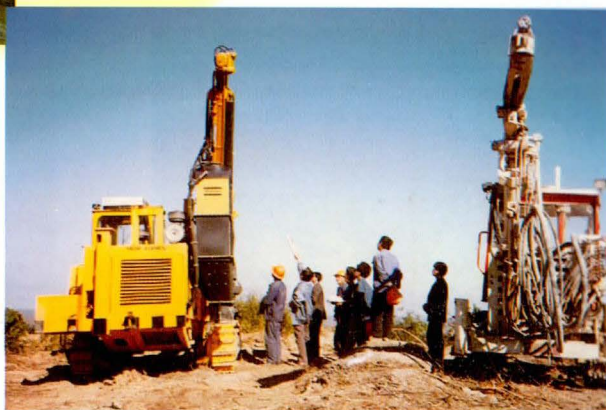
进口液压占车在秦山核电站工地
