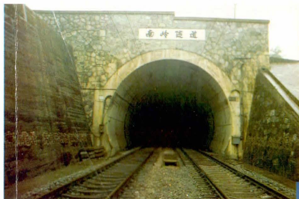
获国家科技成果奖的南岭隧道石灰岩溶流塑粘土大突泥固结技术
