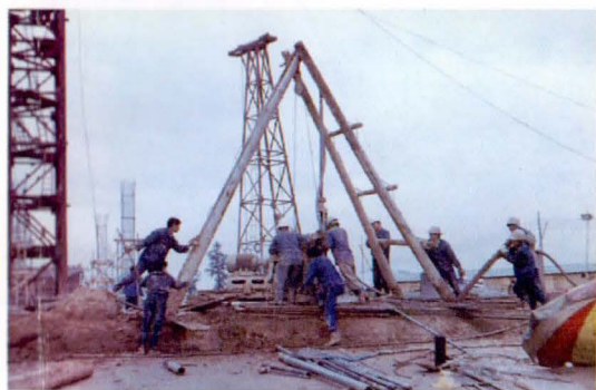
施工队伍在广东岩步大桥建设工地
